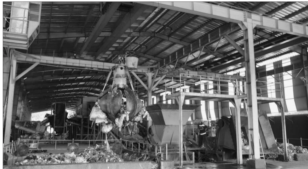
Dây chuyền phân loại rác sinh hoạt tại cơ sở xử lý chất thải rắn Chánh Phú Hòa huyện Bến Cát Ảnh: ST
